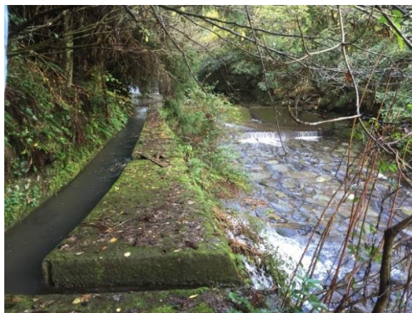
嶽水道(下水道)取水口
