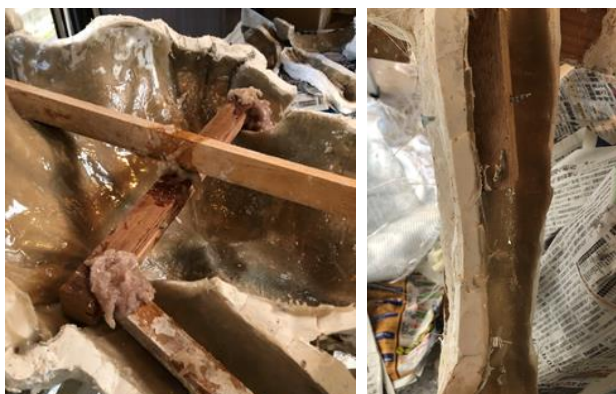
▲ (肩・足) 支え木を固定
